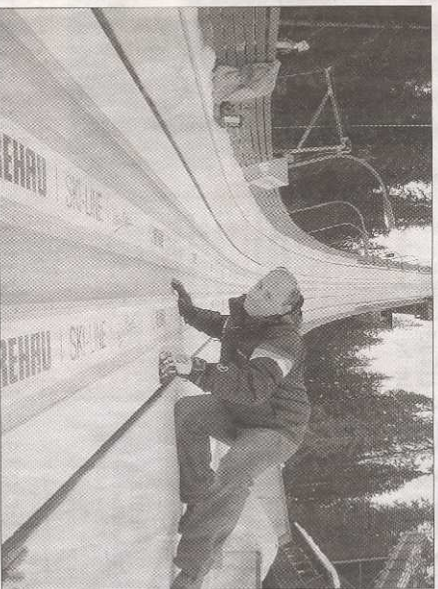
Peter Riedel aus Tellerhäuser prüft die Anlaufspur auf der Großschanze in Trondheim. Das von ihm erdachte System ermöglicht ganzjährig optimale, witterungsunabhängige Trainings- und Wettkampfbedingungen. – Foto: Frank
