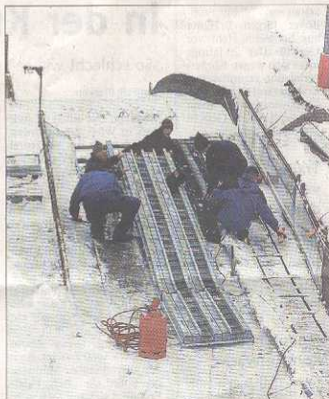
Auf der Winterberger Schanze werden derzeit Kühl-Laufspuren befestigt. Foto: Hermann
