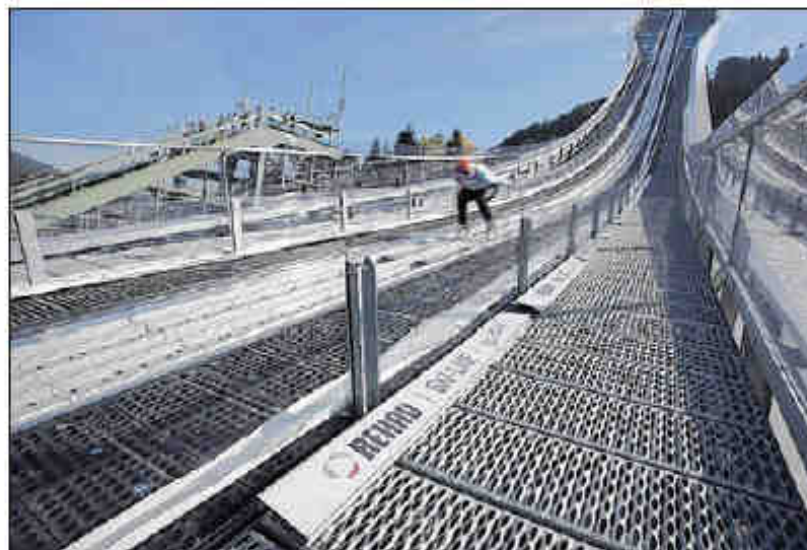
In Garmisch-Partenkirchen sind die Skispringer auf dem neuen Anlaufspursystem von Rehau bestens unterwegs. Foto: Rehau
