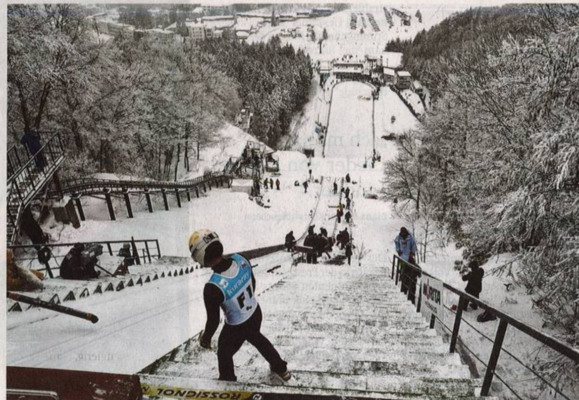
Diese Schanze im japanischen Zao ist die nächste, die mit dem wetterunabhängigen Anlaufspursystem der Peter Riedel GmbH Raschau ausgestattet wird. Die Anlage, auf deren Anlauf im Winter 2012/13 noch nach herkömmlicher Art die Spur in den Schnee geätzt wurde, ist unter anderem Schauplatz von Weltcup-Sprungläufen der Damen. FOTO: PRIVAT
