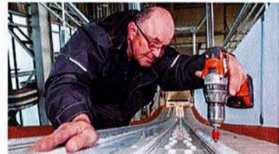
Wolfgang Riedel, der Onkel des Geschäftsführers, ist mit dem Einbau der Anlaufspur beschäftigt.
