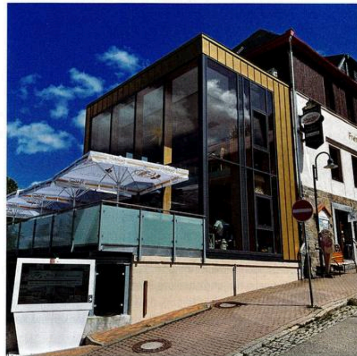
Um den Terrassenbereich zu vergrößern, wurde von Peter Riedel für das Cafe König eine Stahlbauterrasse mit Glasgeländer angebaut.
