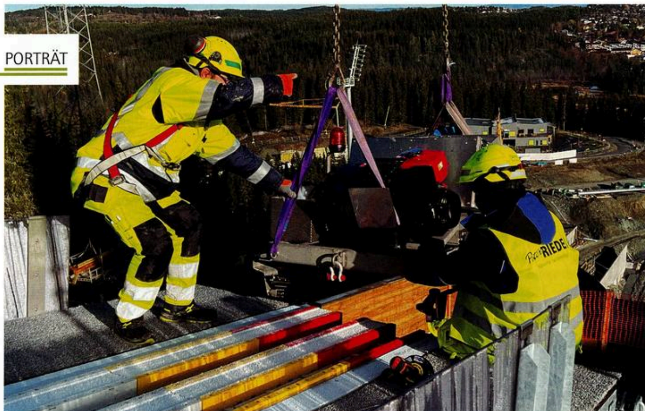
Die Eisfräse aus Edelstahl wurde von Peter Riedel entwickelt: Sie wird in Trondheim, Norwegen, in das Doppelspur-System eingesetzt.
